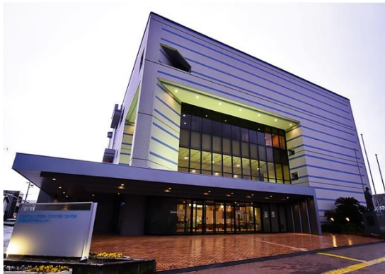
敦賀市民文化センター外観
